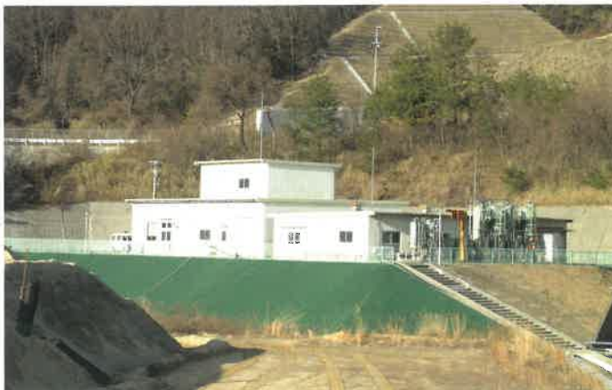
浸出水処理施設
