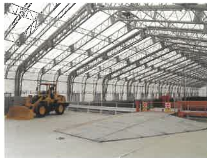
■埋立処分場内観
