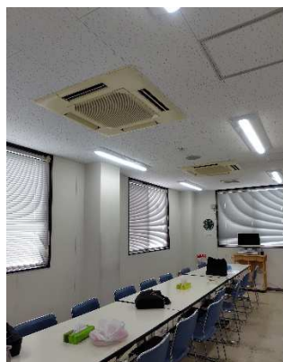
作業員休憩室 ACP-1-7
