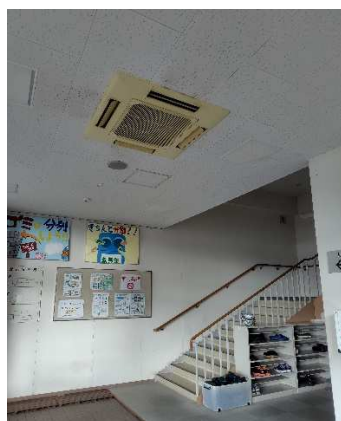
玄関ホール ACP-1-5
